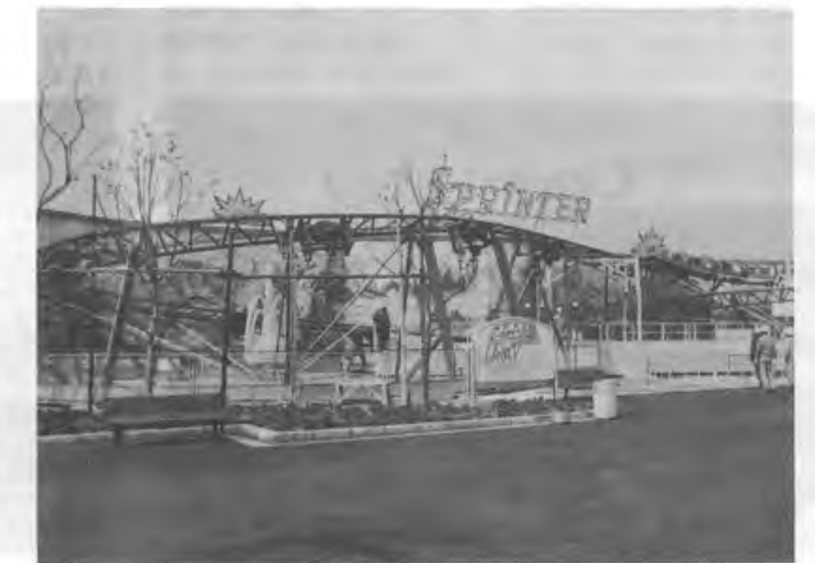
自走式ローラーコースターの「スプリンター」。レールは8の字の曲線で、曲線部の半径が小さいためかなりのスリルがある。
