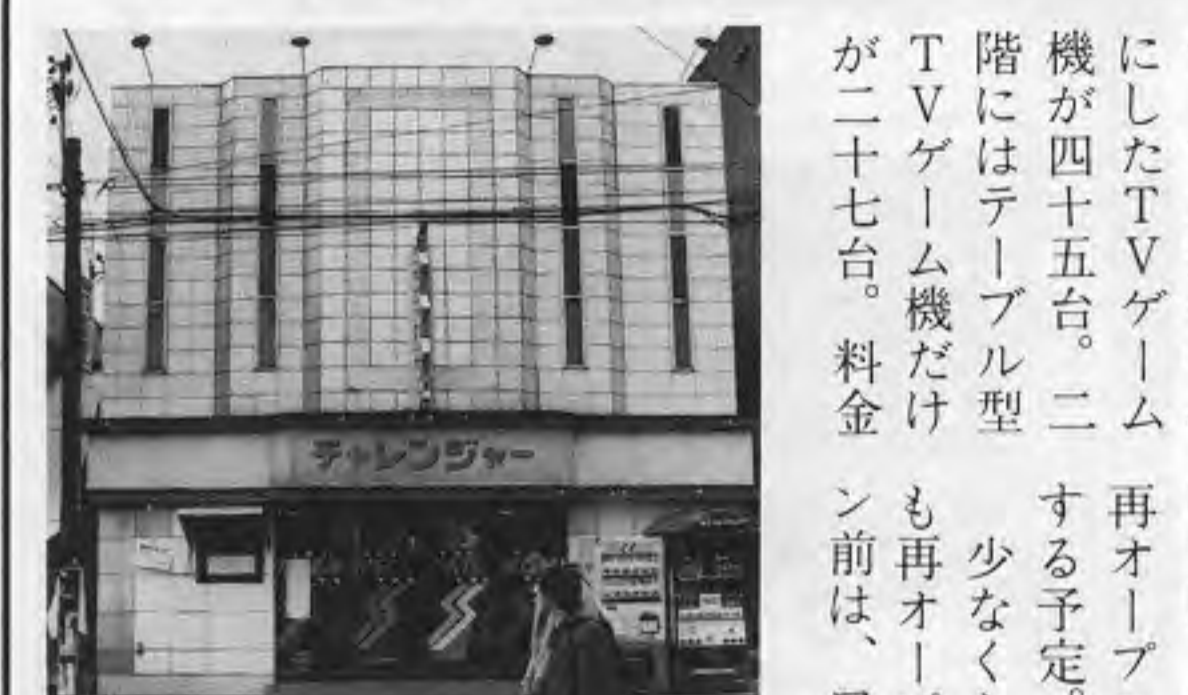
写真は、「チャレンジャー」の外観。右は、同店内のようす
