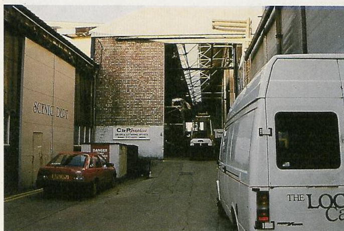
Des bâtiments délabrés.
