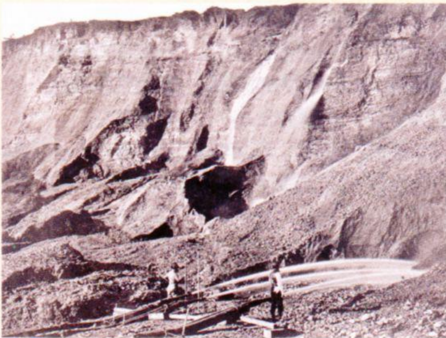
▲ 矿工用高压水枪冲刷一处砂金矿。
