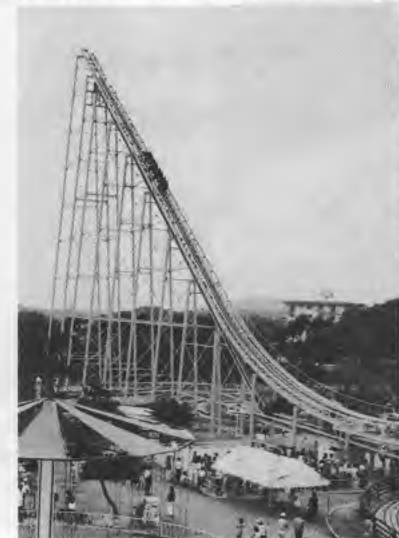
「最も高いコースター」となった東条湖ランドの「ループ・コースター」。明島特殊製業が作ったもので、スタート時に最高位まで車両は引上げられ、落下加速で宙返りする(写真は本誌撮影のもの)。
