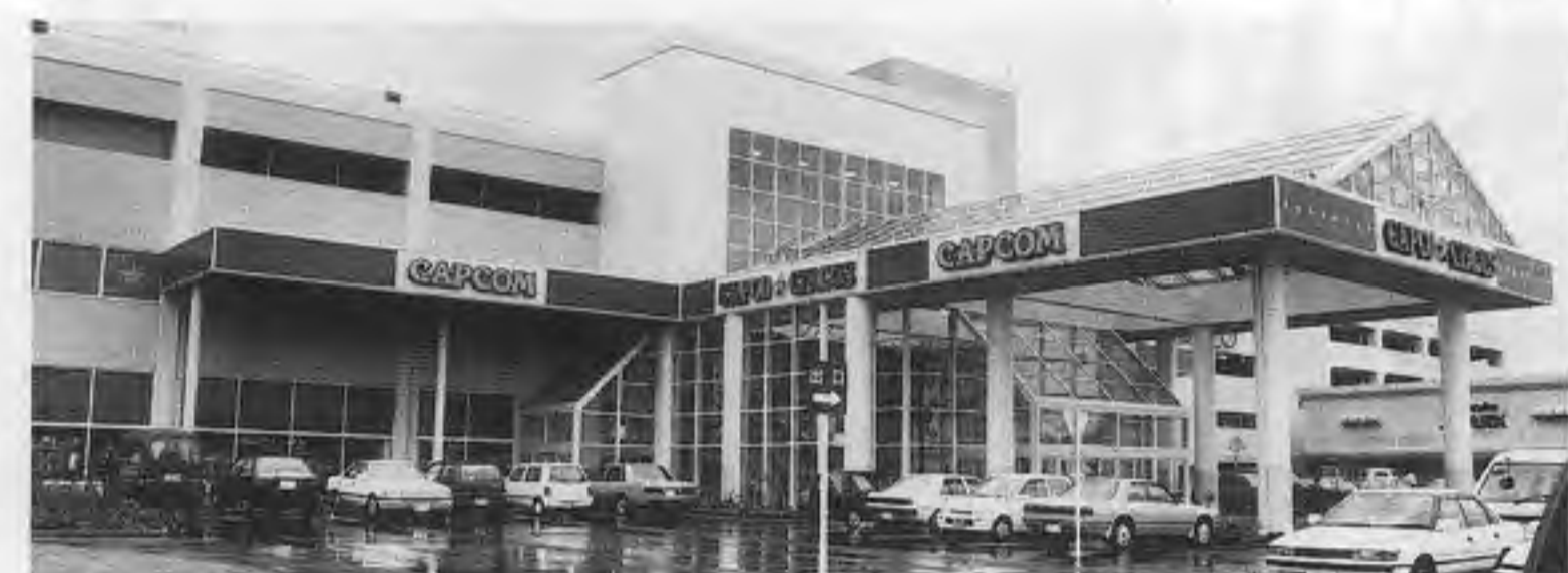
「カプコサーカス」の入口部分と同ロケの建物の様子
