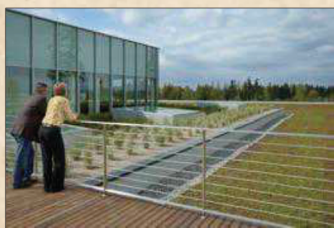
▲绿化的屋顶不但环保，植物也可以有效吸收阳光照射的热量，降低建筑内部温度，节省冷气费用开支。
