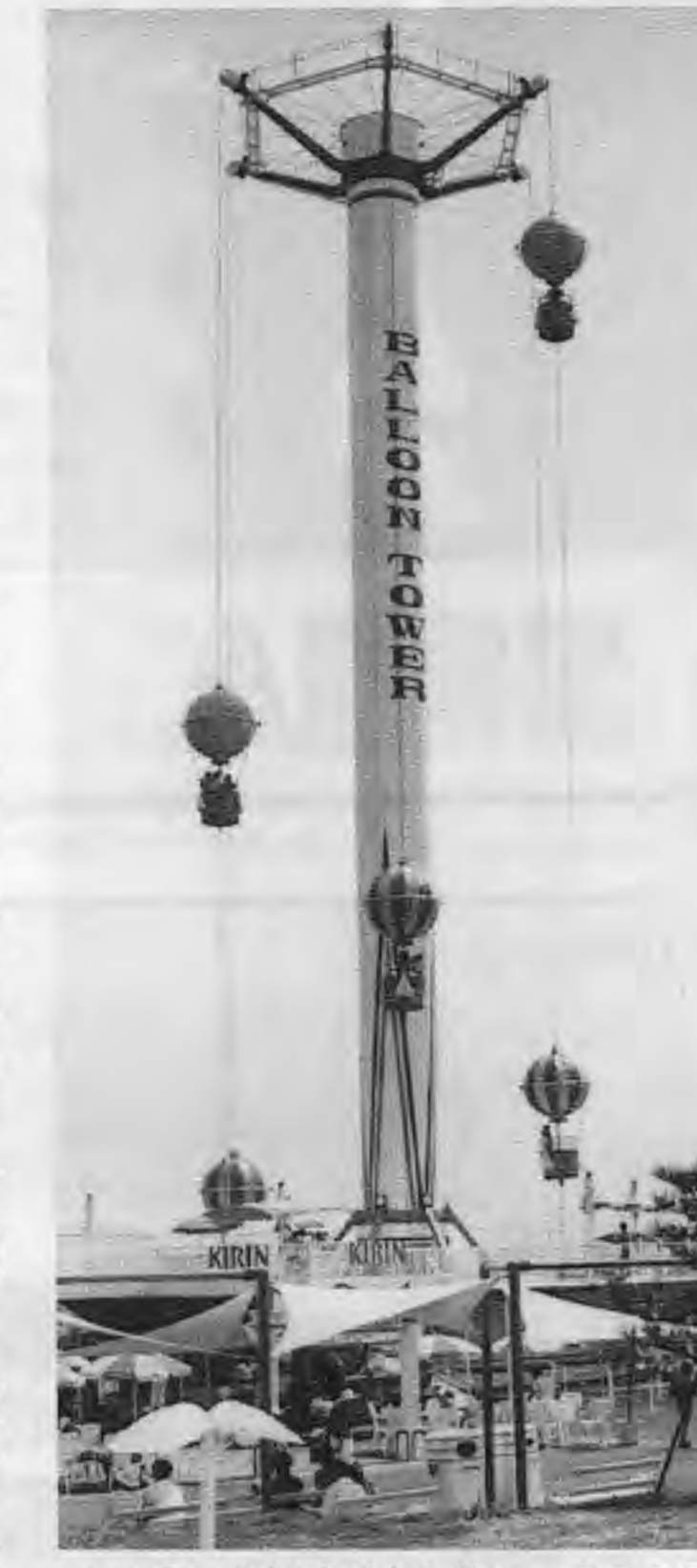
2人乗りの気球が高さ約44mまで上昇下降する「パルンタワー」で、同博覧会では高さが高い遊園施設
