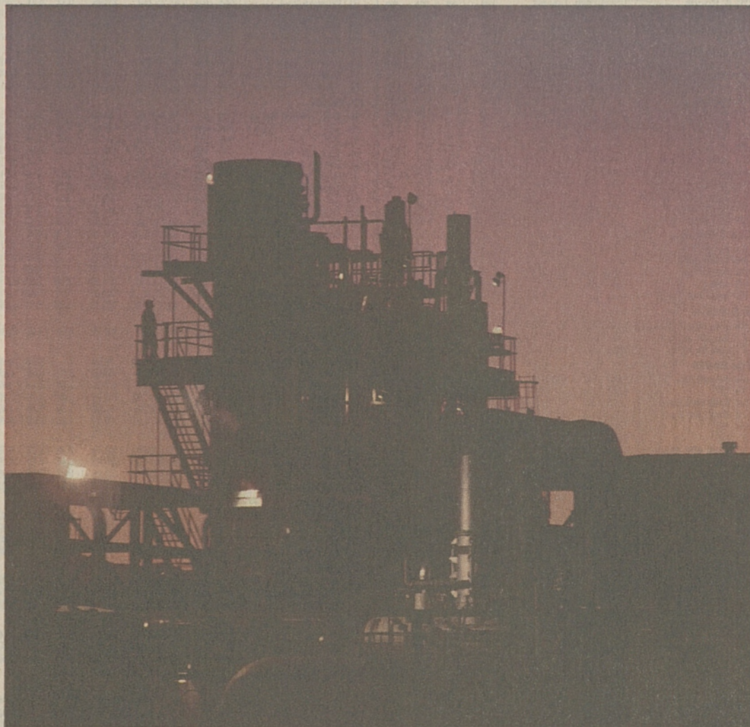
Energie: gasgefeuertes Kombikraftwerk mit einer Leistung von 125 Megawatt, Sumas (USA), Bau, Betrieb und Miteigentum durch die Calpine Corporation.
