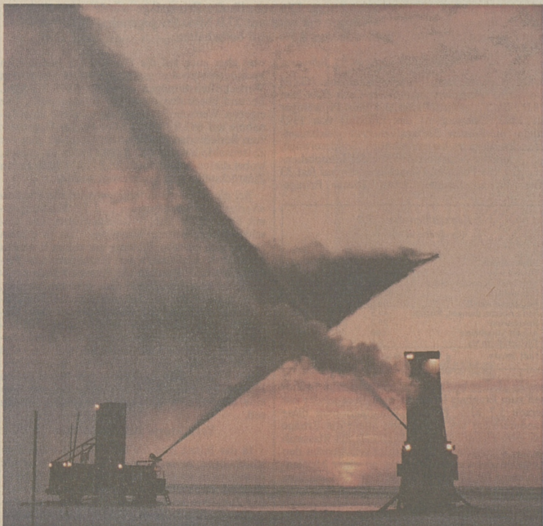
Dienstleistungen: Versprühen von Eiskristallen durch die Sandwell Inc. zur Herstellung von künstlichen Bohrplattformen aus Eis, Beaufort See, Arktis.
